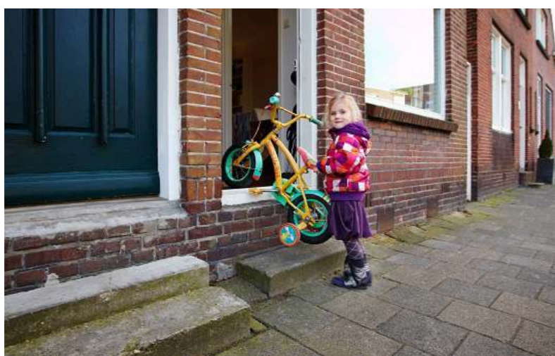
verzakkingen door bodemdaling
