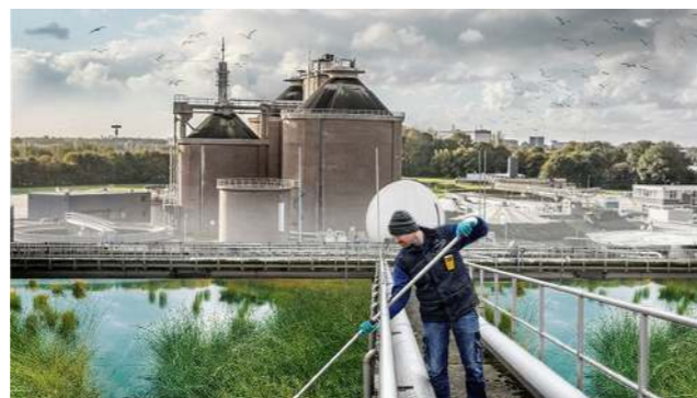
Nazuivering van effluent in een groene 'waterharmonica'
